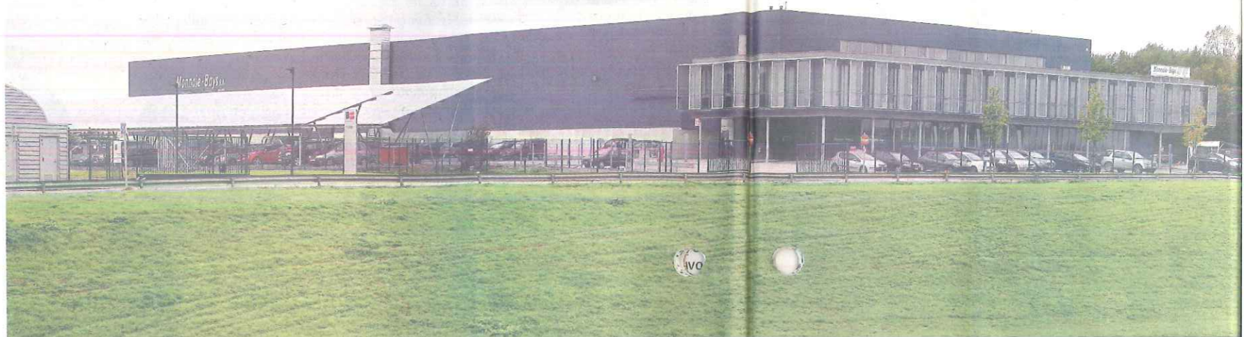
▶ Sur le car-port (à gauche sur la photo), on a installé 1.011 panneaux photovoltaïques qui permettent d'éviter le
